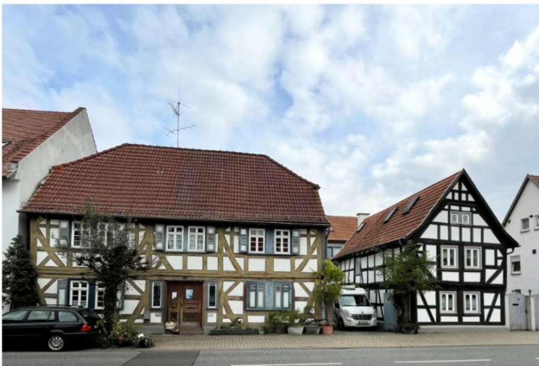
Abb. 4.23 Beispiel-Gebäude für eine gelungene Sanierung einer Fachwerkfassade
