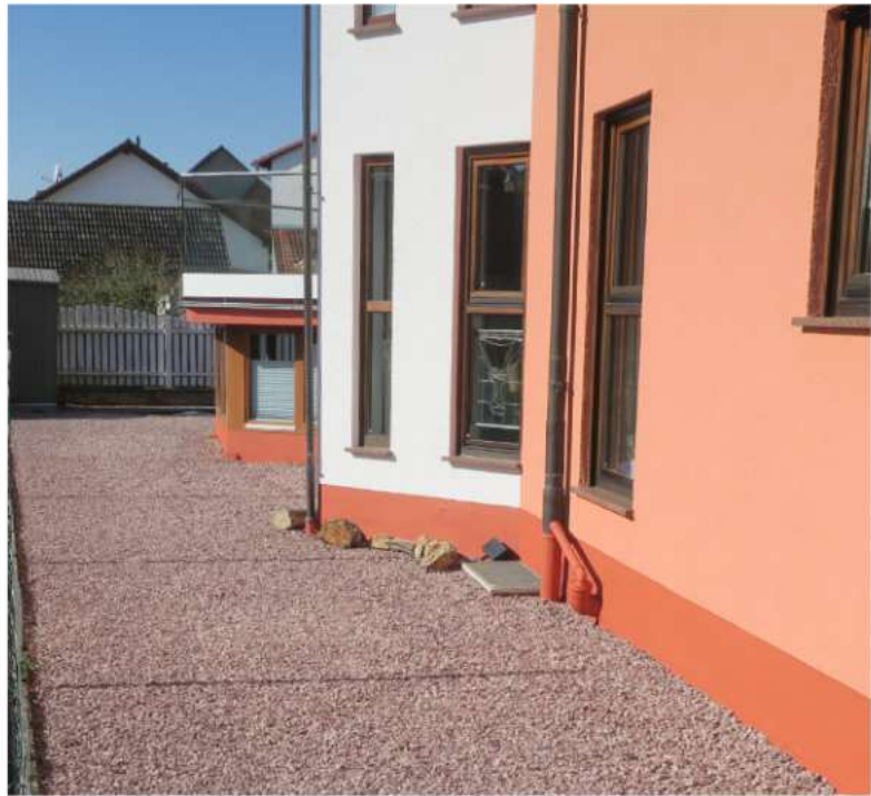
Abb. 4.43 gekiester Garten, der zur Überhitzung der Umgebung beiträgt und vermieden Und rückgebaut werden sollte
