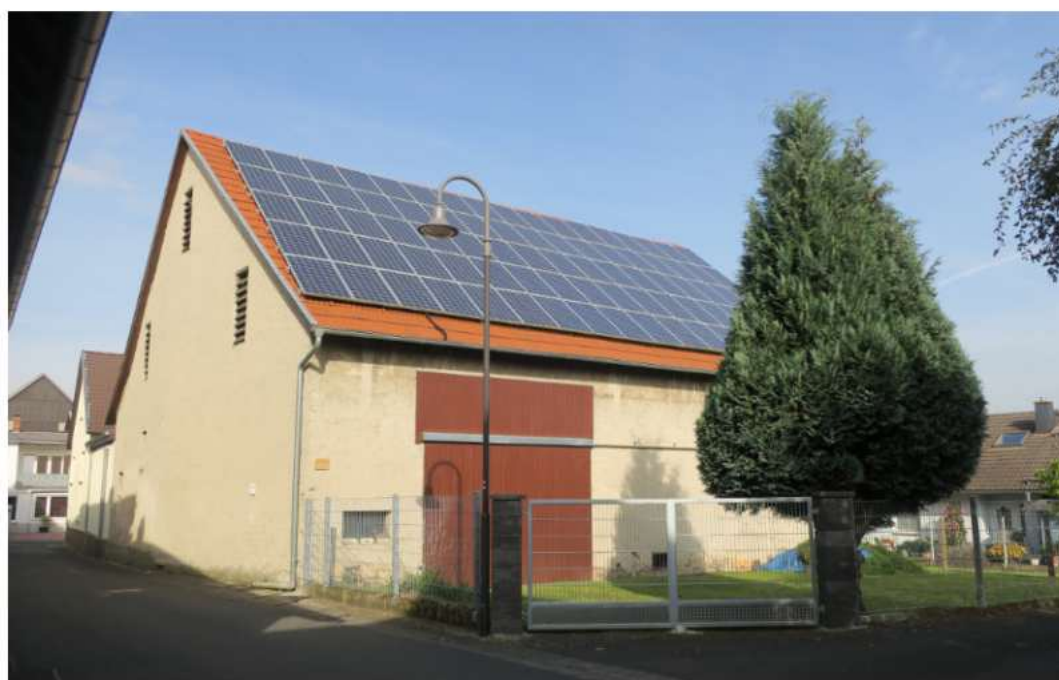
Abb. 4.42 Photovoltaik-Anlage auf einer großflächigen Dachfläche einer Scheune
