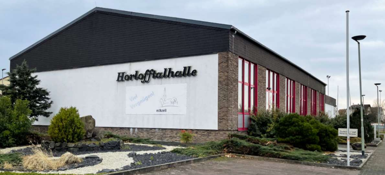
Abb. 2.22 Mehrzweckhalle Horloffthalhalle, im Ortsteil Echzell
