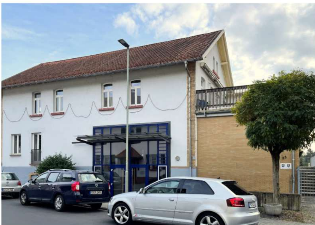
Abb. 4.8 „Alte Molkerei“ - Nordseite
