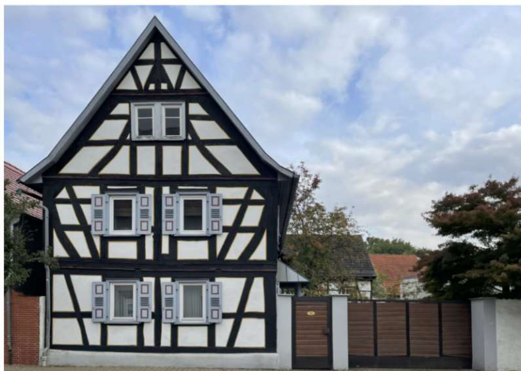
Abb. 4.17 Denkmalgeschütztes Haus aus der Mitte des 18. Jahrhunderts
